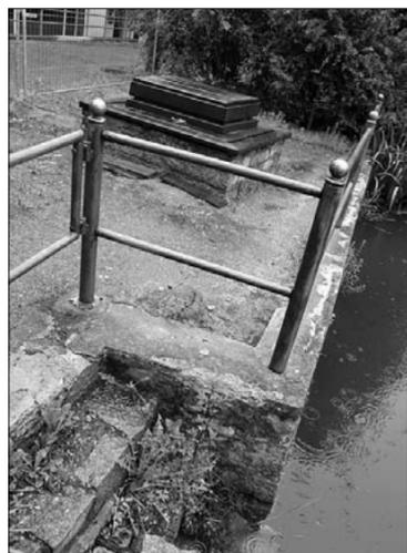
Die Mauer und das Auslaufbauwerk sind undicht.
