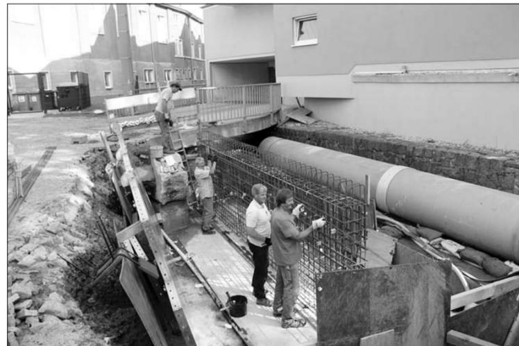
**Stahlflechten für den ersten Abschnitt der Ufermauer, das Fundament ist bereits aus Beton gegossen.**
