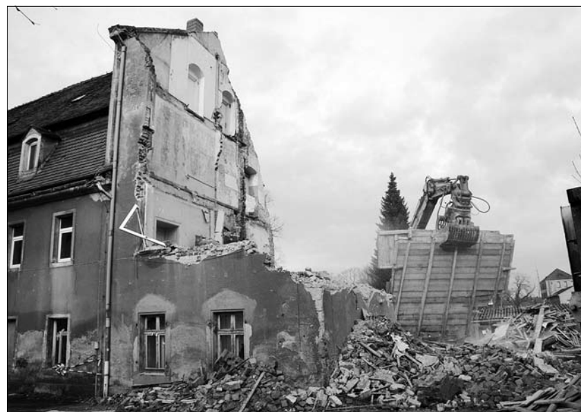
Das abgerissene Gebäude beherbergte einst einen Kindergarten.
