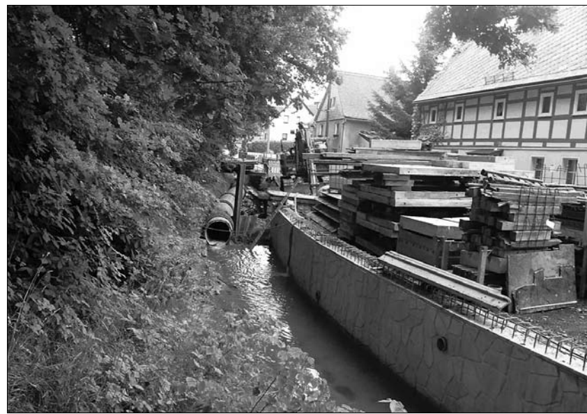
Das erste Segment des neuen Bauabschnittes an der Ufermauer ist bereits fertiggestellt.
