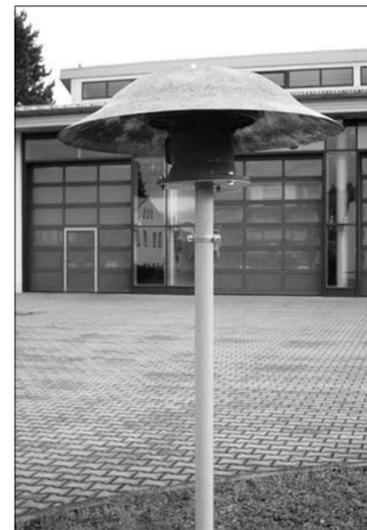
ersetzt. Im Gegensatz zu den alten Sirenen, die den Heulton mechanisch erzeugen, wird das Signal in den neuen über vier elektronisch angesteuerte Lautsprecher erzeugt.
