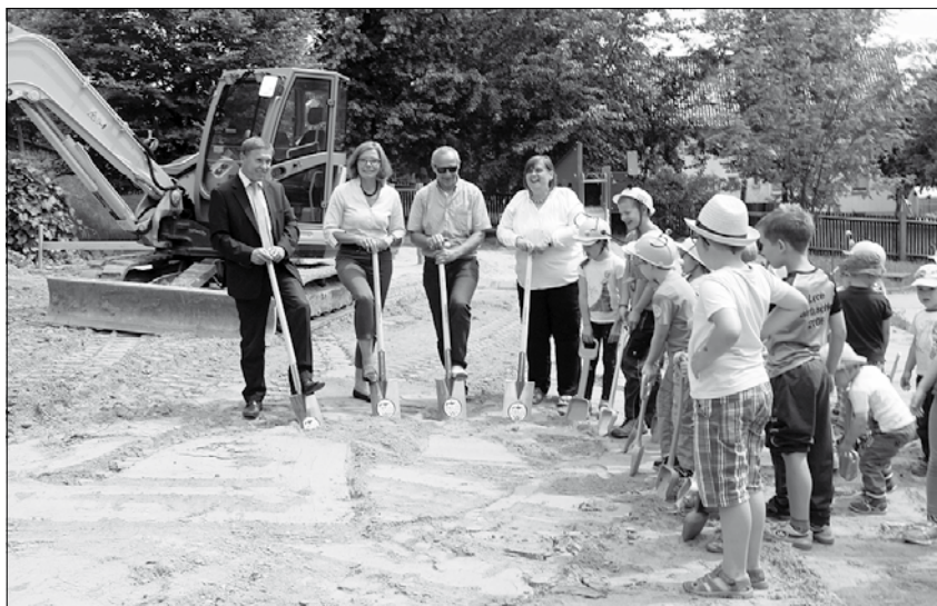
Gemeinsam beim Spatenstich: Aloysius Mikwauschk, Barbara Lüke, Kerstin Kretschmar und der Baubetrieb
