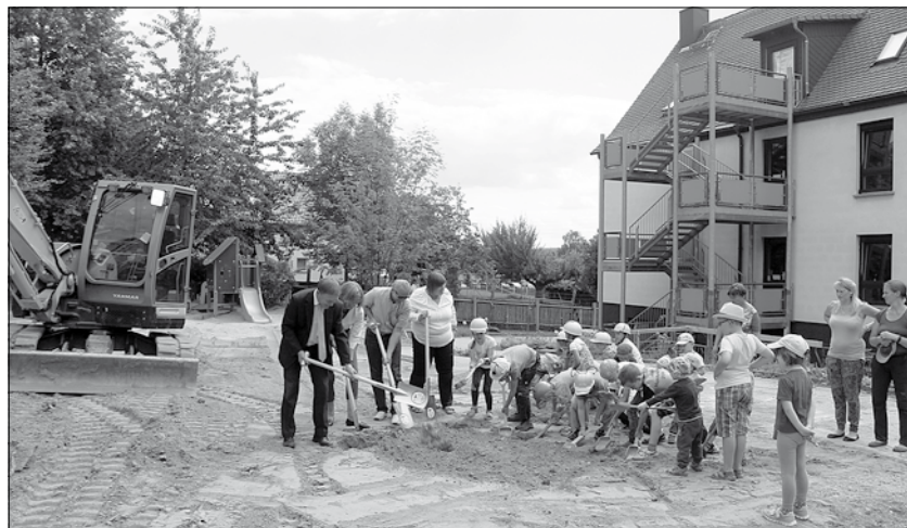
In Oberlichtenau entsteht ein Neubau für die Krippenkinder neben der städtischen Kita. Im Frühjahr 2017 werden die Kleinsten dort einziehen.
