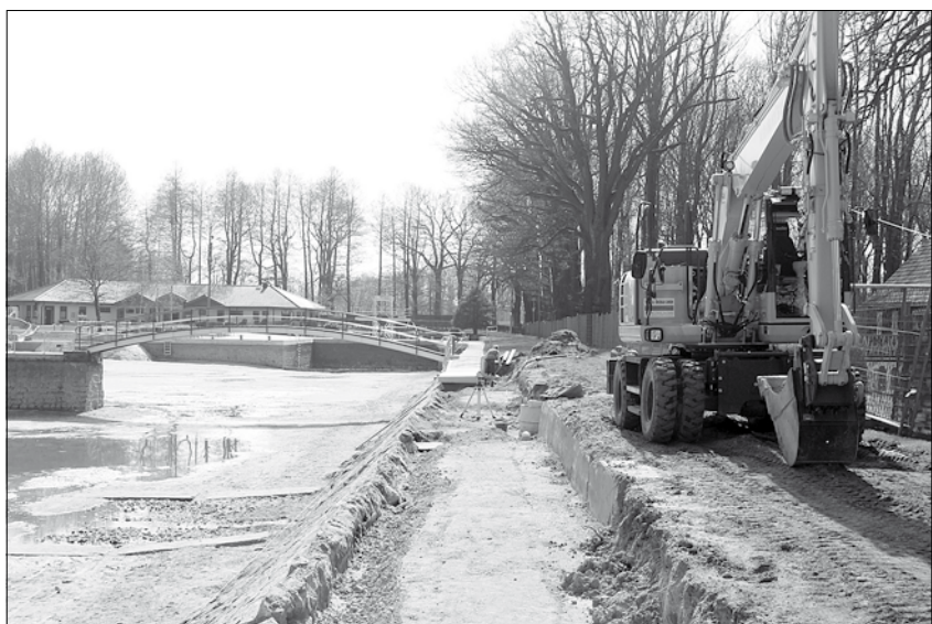
Zur Saisonöffnung im Walkmühlenbad konnte ein weiterer Bauabschnitt der im Frühjahr sanierten Beckenumrandung übergeben werden. Nach Saisonende begannen weitere Bauarbeiten zur Fortsetzung der Sanierung.
