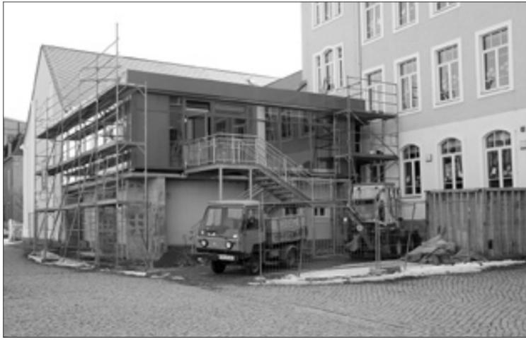
Bis Mitte April werden in Abhängigkeit der Witterungsverhältnisse die Arbeiten an der Außenfassade mit Dämmung, Putz und Farbanstrich fertiggestellt.
