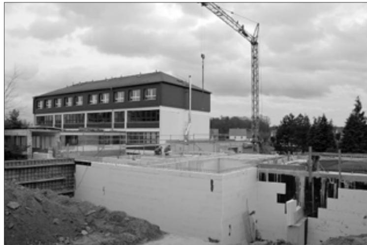
**Mittlerweile ist die Decke bereits auf dem Sockelgeschoss verlegt und der Bau hat zum Winterbeginn einen guten Fortschritt erreicht.**
