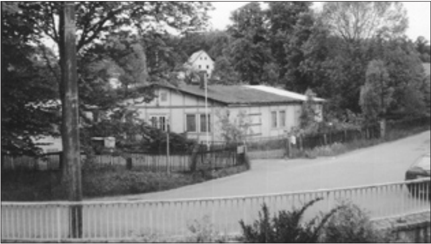
Dieser Barackenbau An der Pulsnitz war längst kein Aushängeschild mehr. Jetzt ist er abgerissen.
