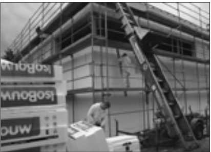
Außendämmung am Rohbau.
