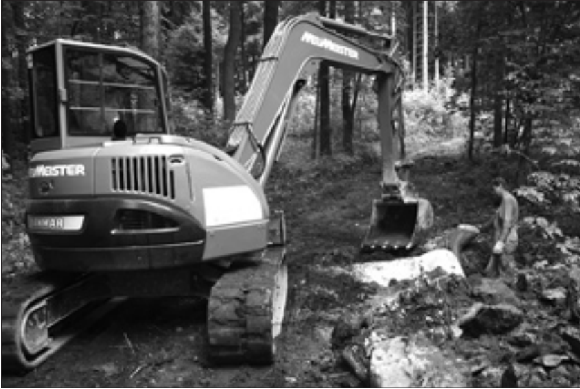
Zu den ersten Arbeiten beim Wegebau im Stadtwald gehörte der Einbau eines neuen Durchlasses für das Hahneflüsschen.
